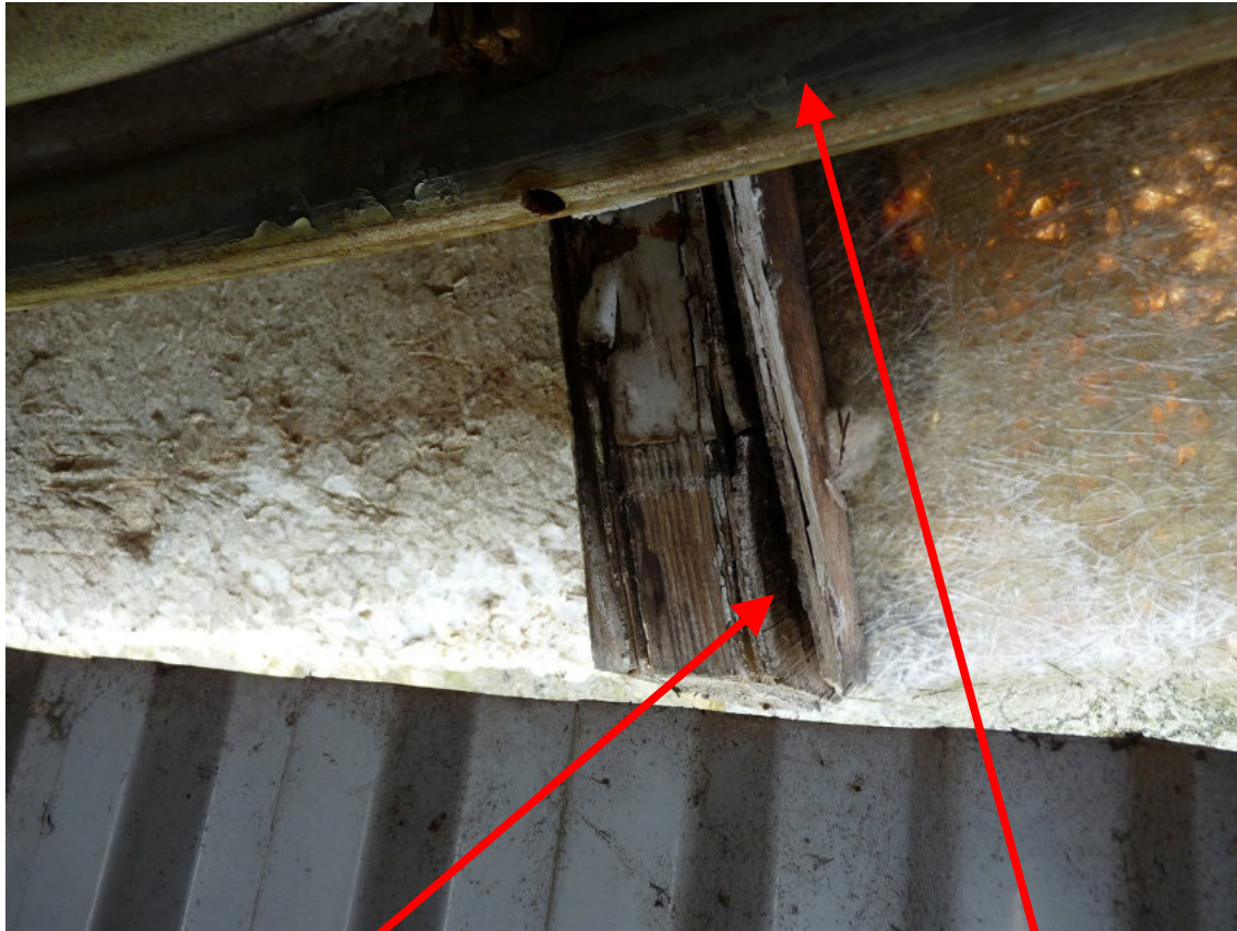
Sperrholz aufgeweicht, gespalten und verrottet
