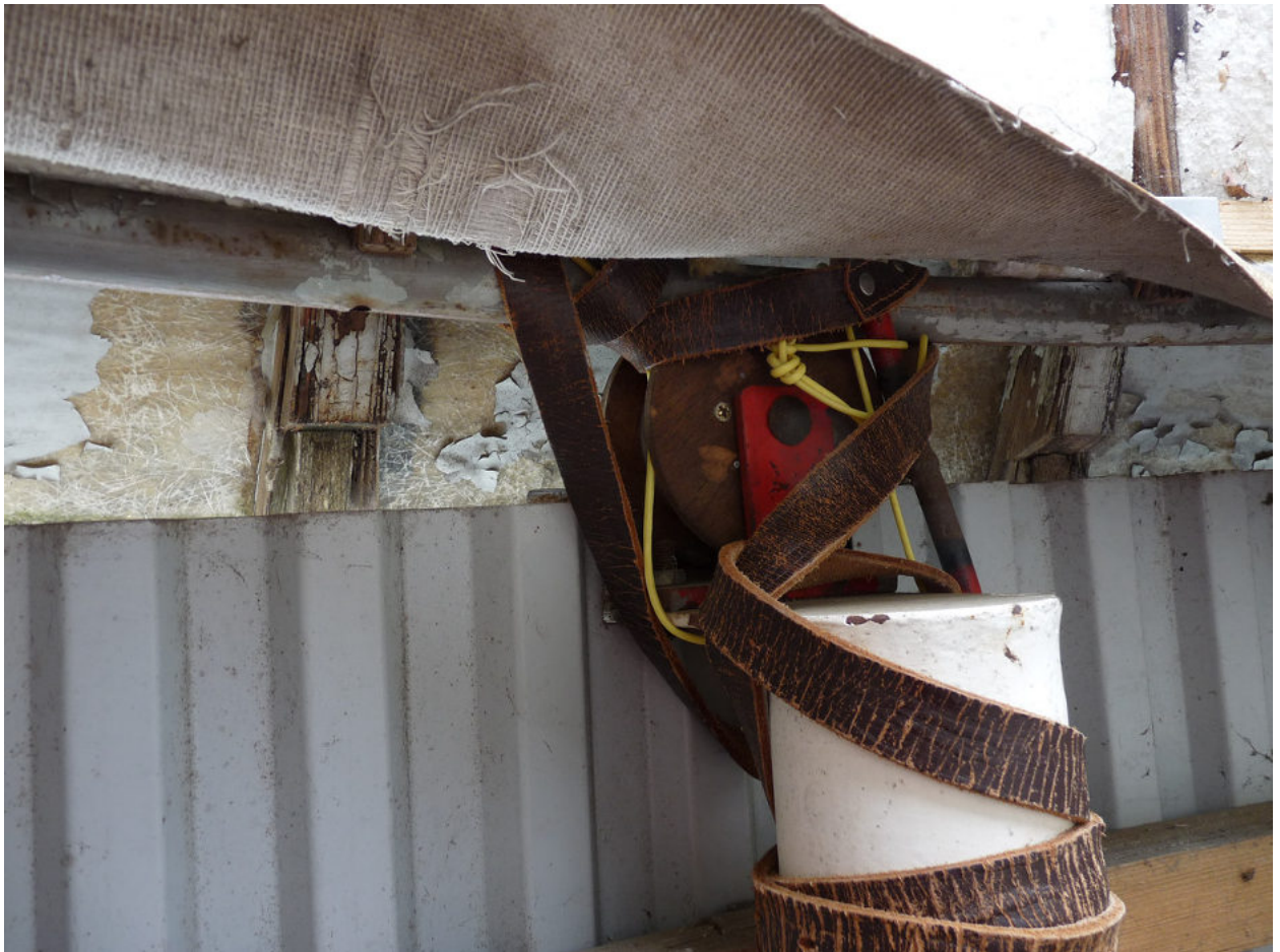
3 Laufrollen (einst mit Fahrradschlauch bezogen für ruhigen Lauf) mit Lederriemen gesichert wegen Orkanwarnungen im Februar 2020.
