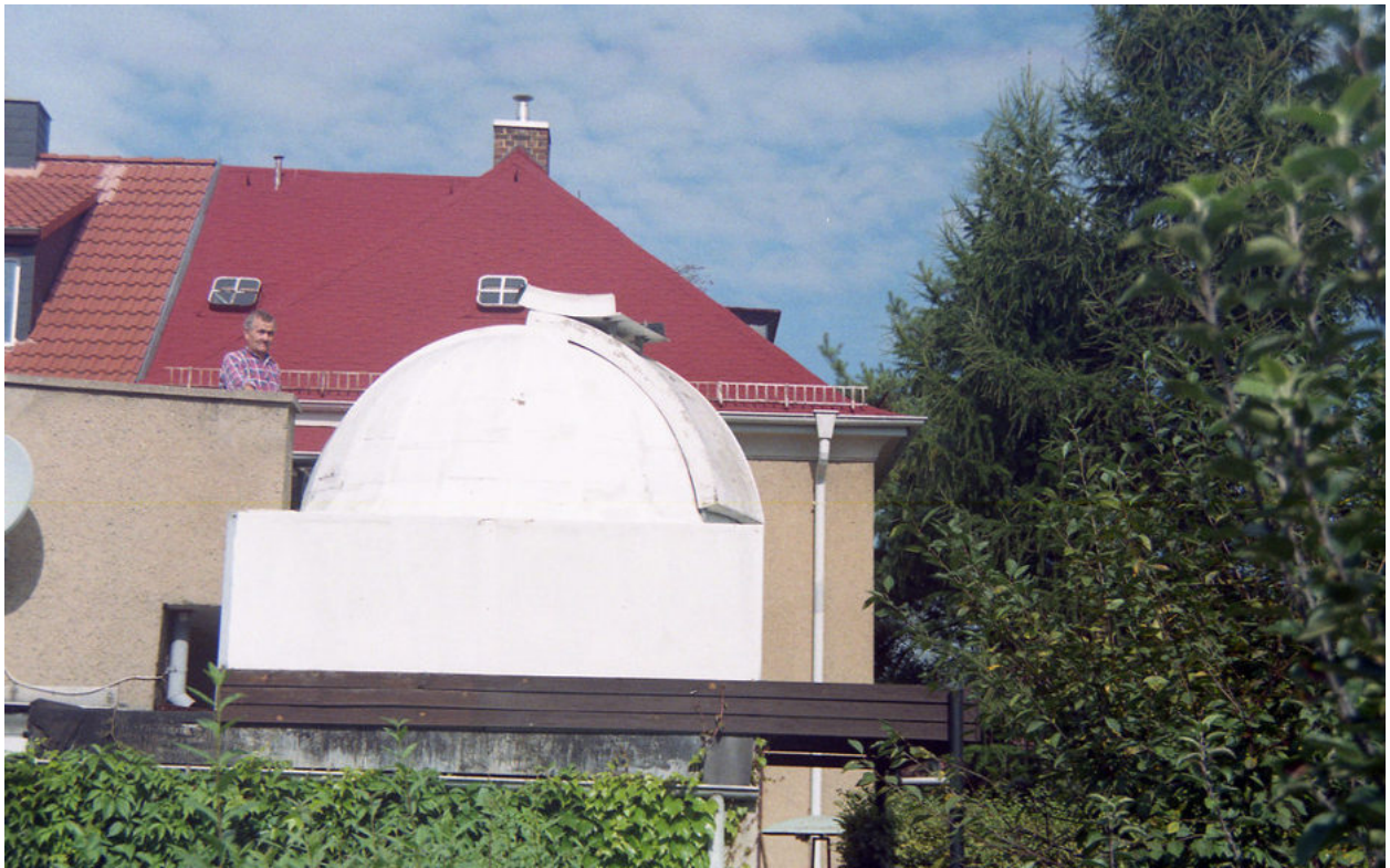
Um 1994, noch mit rechteckigem Unterbau aus Asbestzementplatten.
