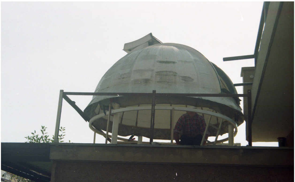
Umbau auf runden Unterbau, die 3 Laufrollen stehen bereits auf den neuen Stahlsäulen.
