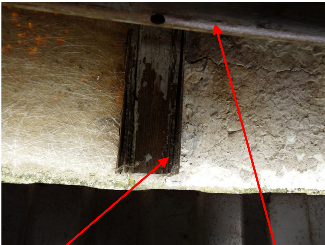
Sperrholz aufgeweicht, gespalten und verrottet
