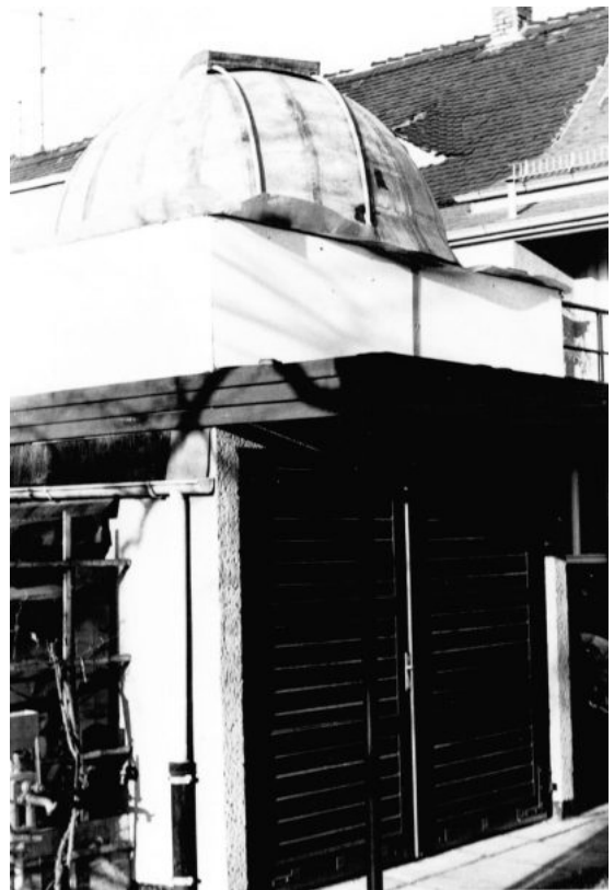
Erste Erprobung auf dem Unterbau. Kuppelverkleidung: GFK-Schindeln (ex Gewächshaus).
